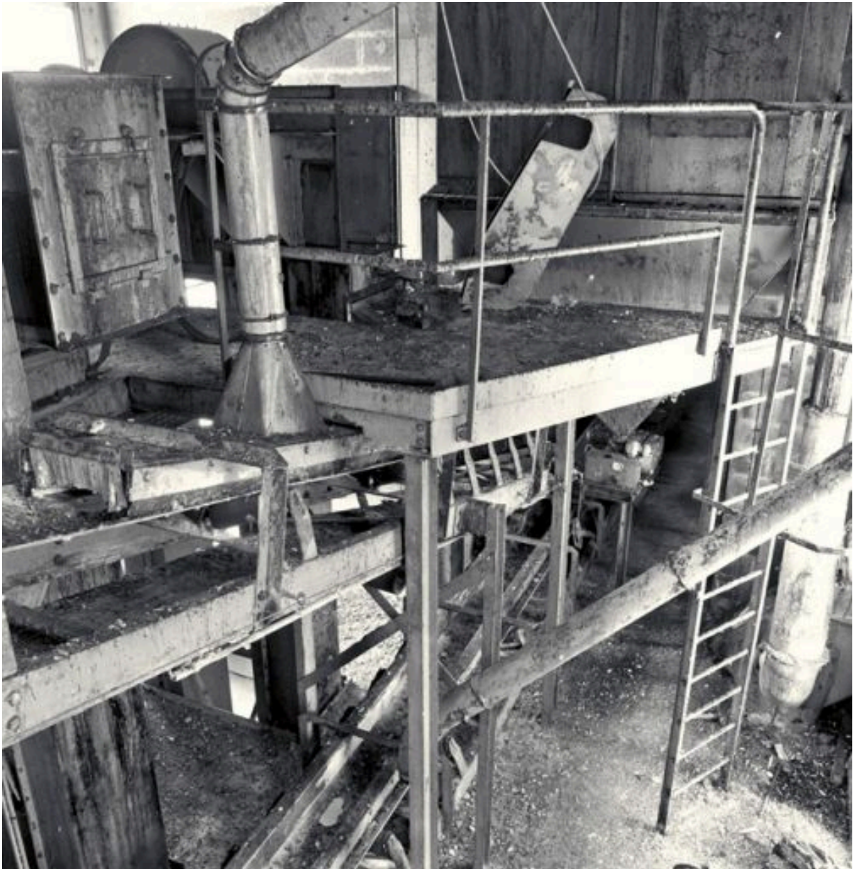
La cage des élévateurs : jonction des transporteurs à bandes
