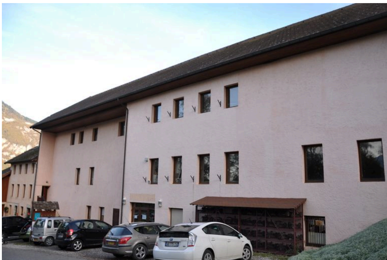
Façade antérieure ouest
