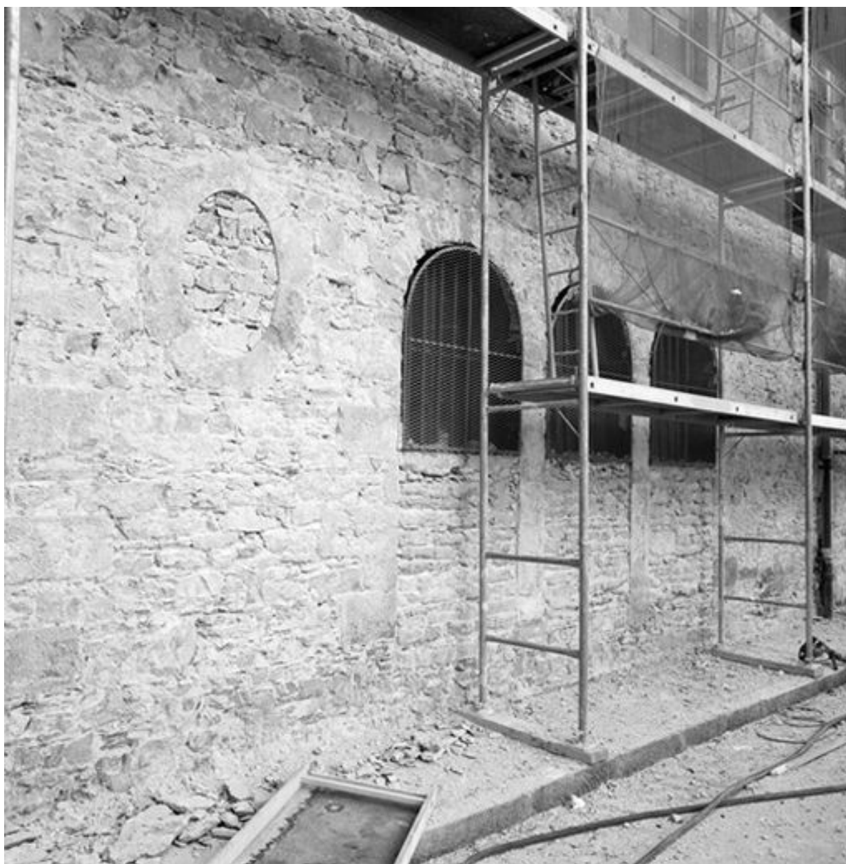
Grand cloître, galerie ouest, partie sud donnant sur la place des Chartreux durant les travaux de mars 2002, détail de la deuxième travée
