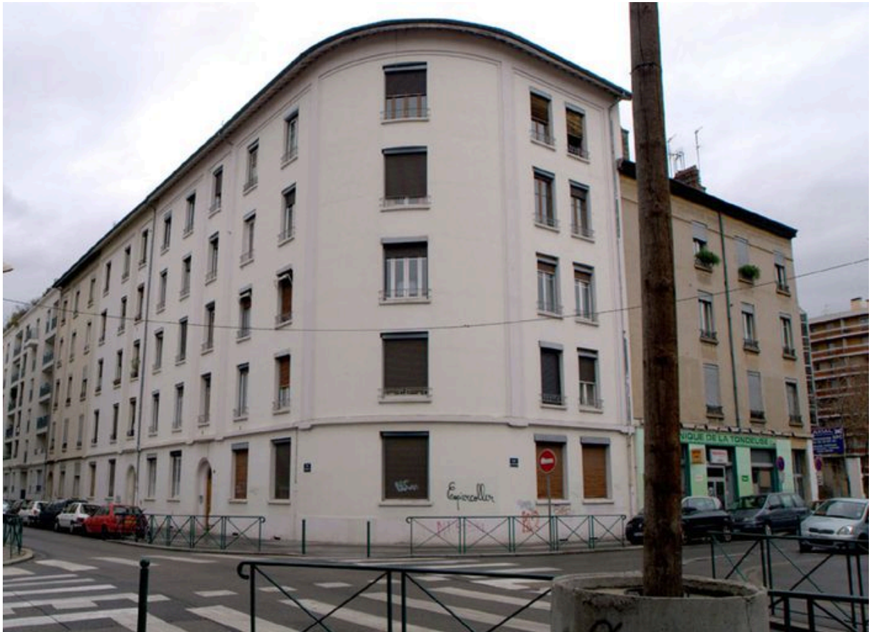
Vue d'alignement des façades rue Tourville
