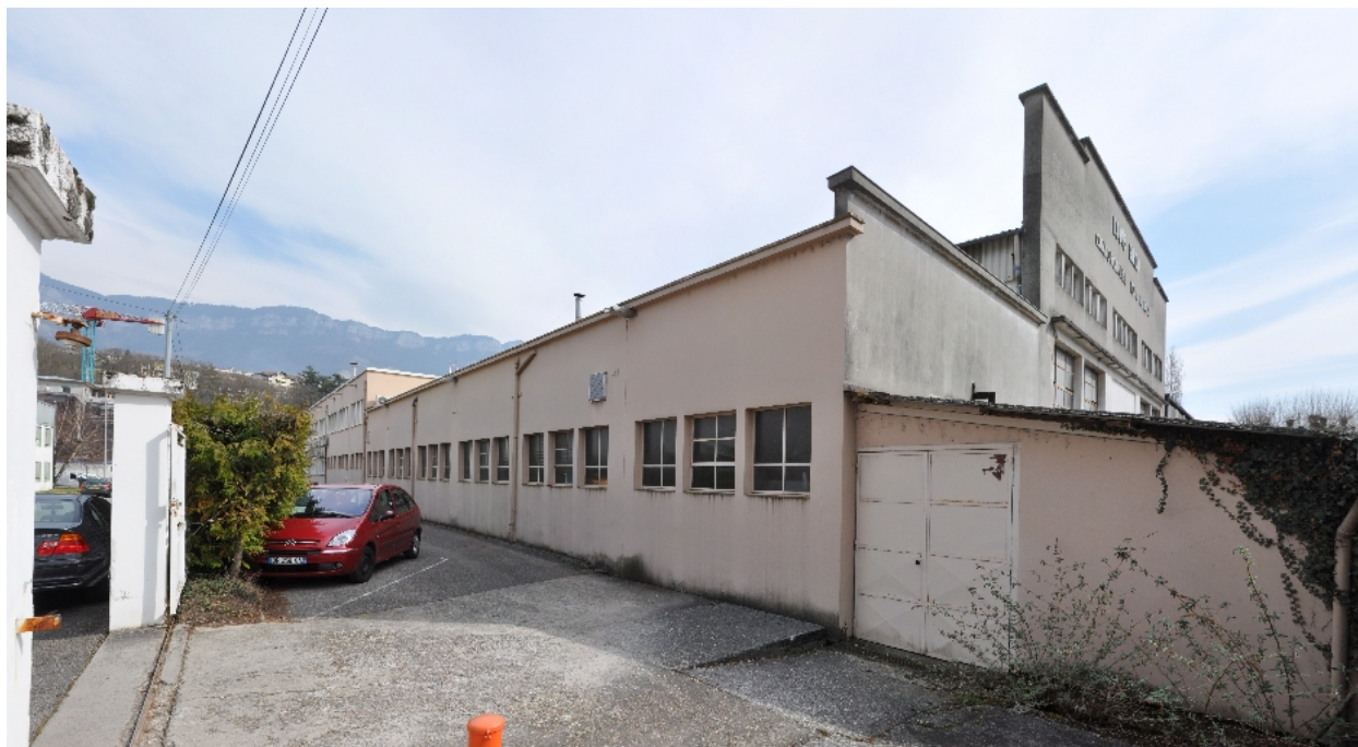
Ets Louis Girod, façade nord sur rue Saint-Eloi
