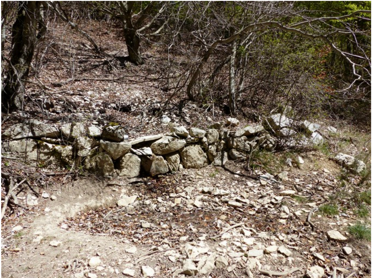
Fontaine haute de Chanaux. Vue d'ensemble prise du nord-ouest.
