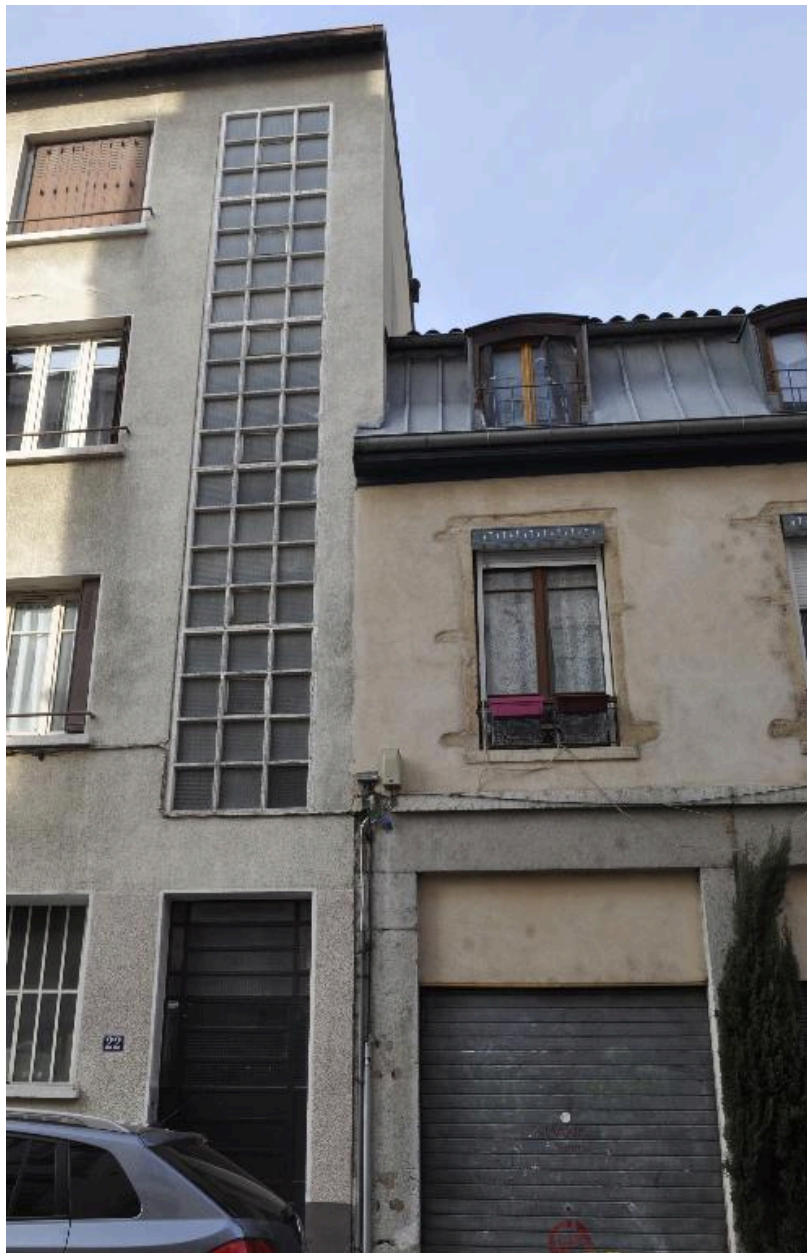
Elévation sur rue, vitrage éclairant l'escalier latéral en revers de façade
