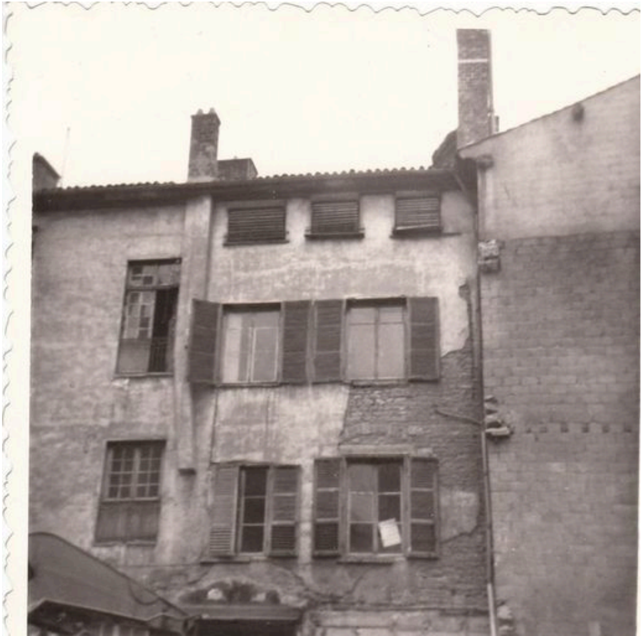
Elévation postérieure lors des travaux du bâtiment ISARA (2nd phase), photographie ancienne, 1972
