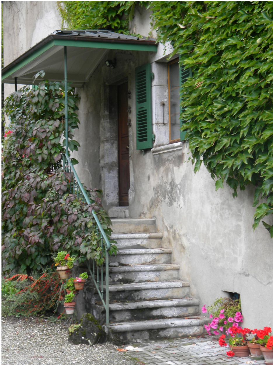
Vuie de l'escalier extérieur menant au logis ouest.
