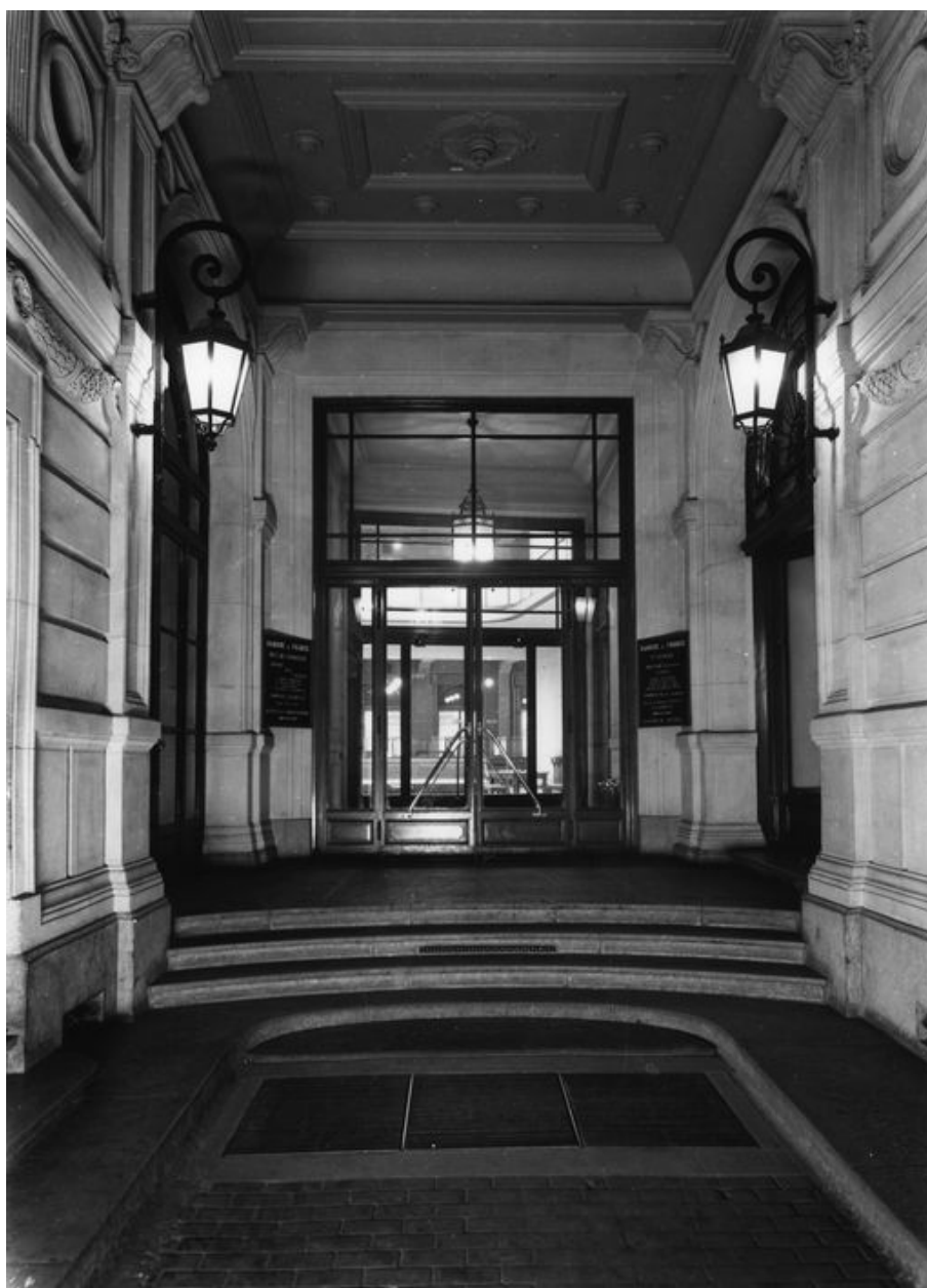
Vue du porche d'entrée en 1959, avant l'installation d'un sas de sécurité (Banque de France, archives historiques, 1Fi 0497-14, photographie, 1959-1960).
