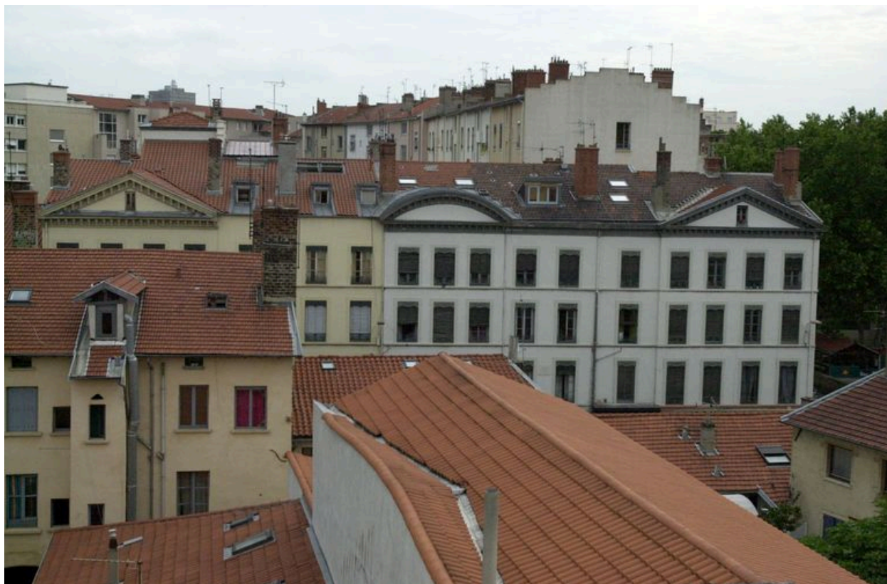
Elévation postérieure depuis le sud
