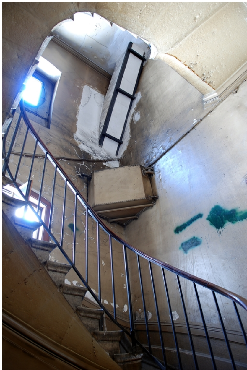
Corps de bâtiment sud : cage d'escalier et réservoir d'eau
