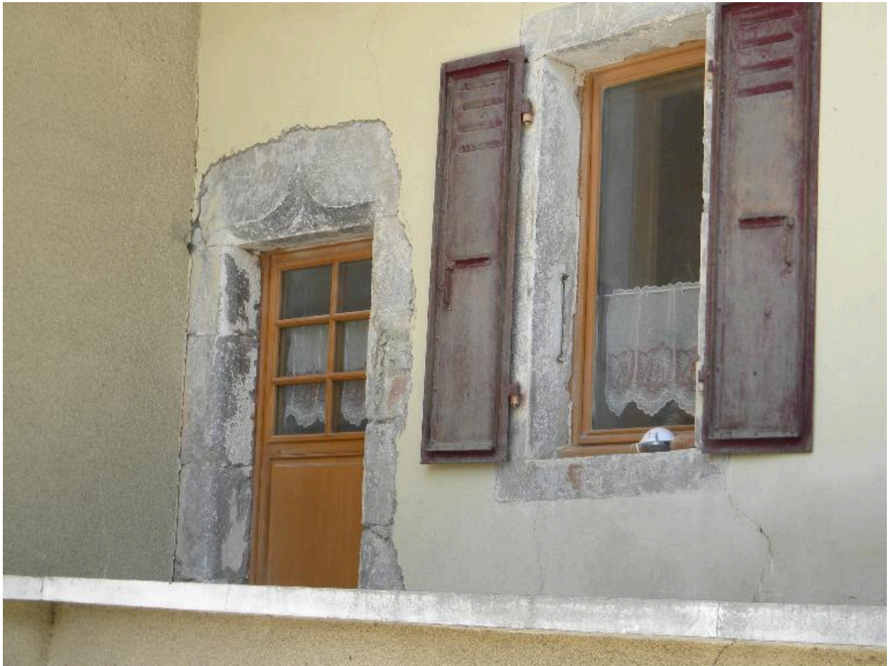
Linteau de porte à accolade sur une ancienne ferme remaniée (2008 D12 2983, 3126).
