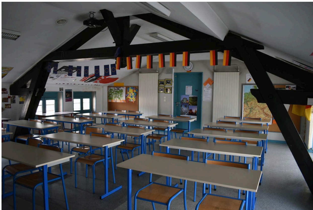
Bâtiment F : salle de classe, 2e étage
