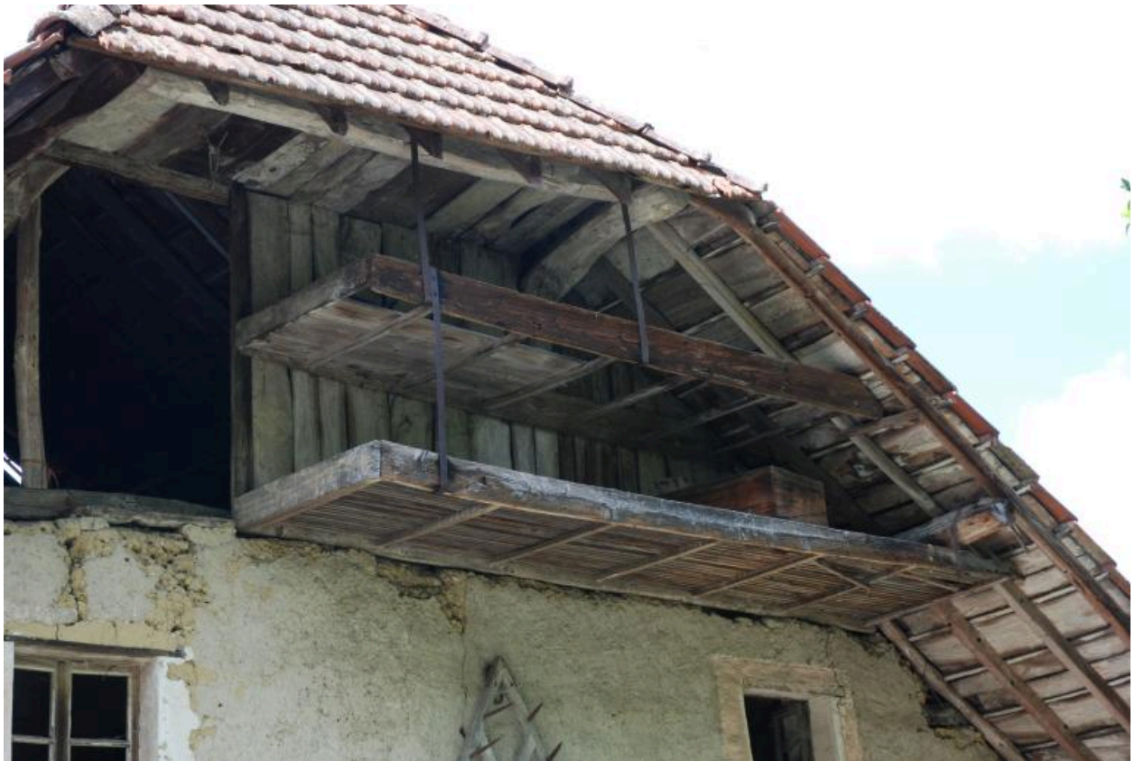
Vue du mur pignon est : détail des claies de séchage.
