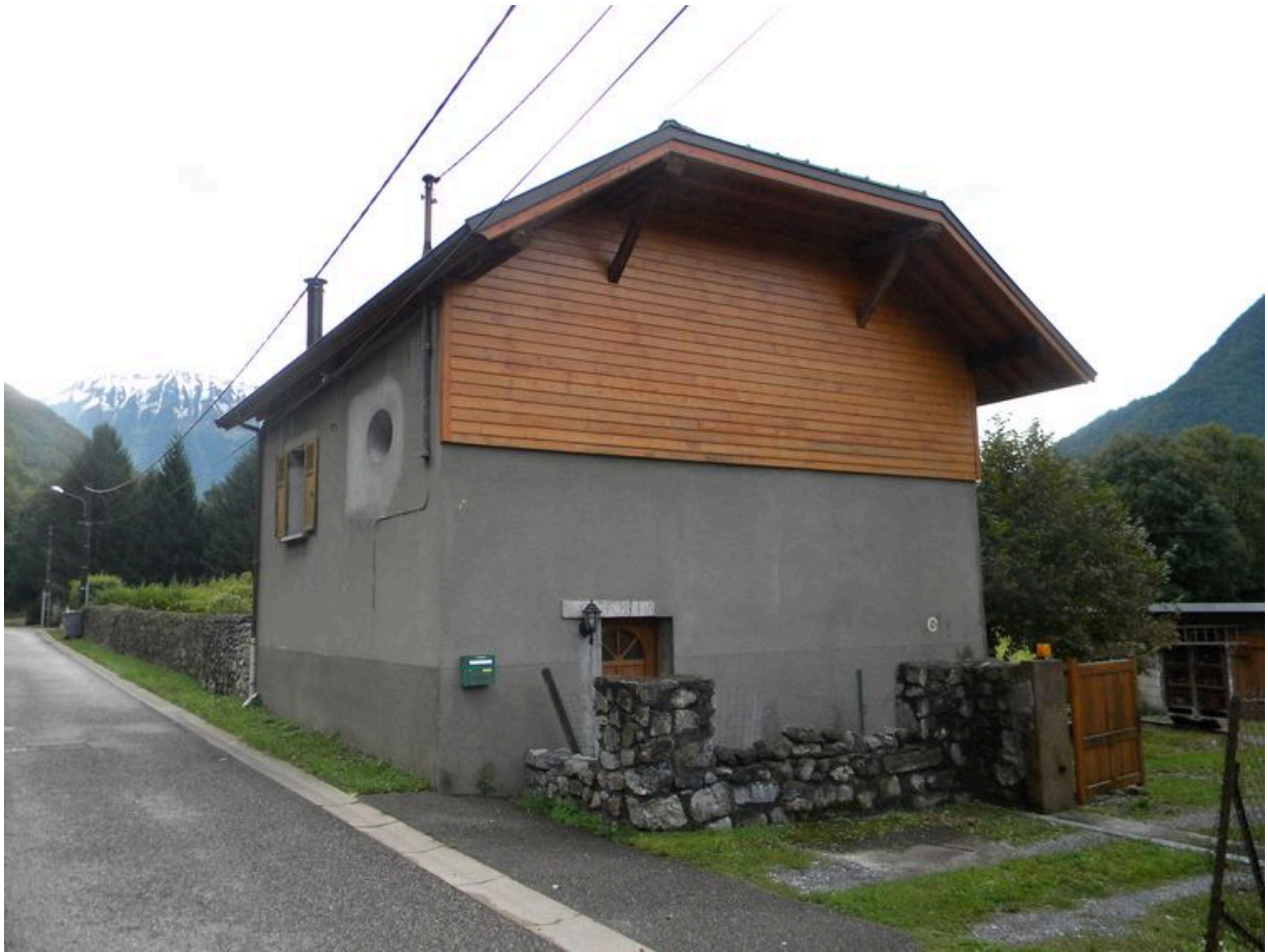
Vue d'un bâtiment transformé à la sortie est du hameau (2008 B5 884)
