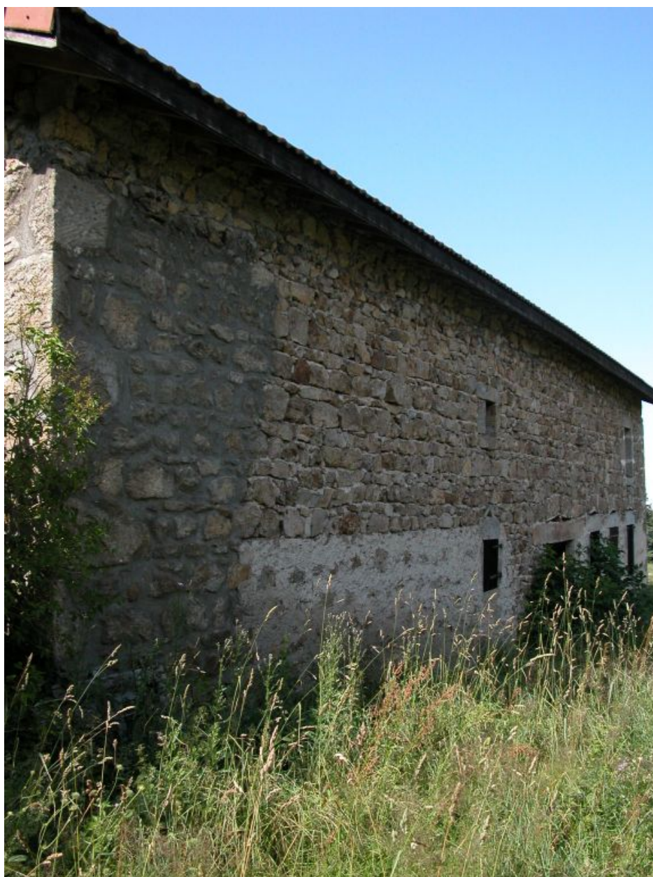
Vue d'ensemble du mur gouttereau sud de la jasserie.
