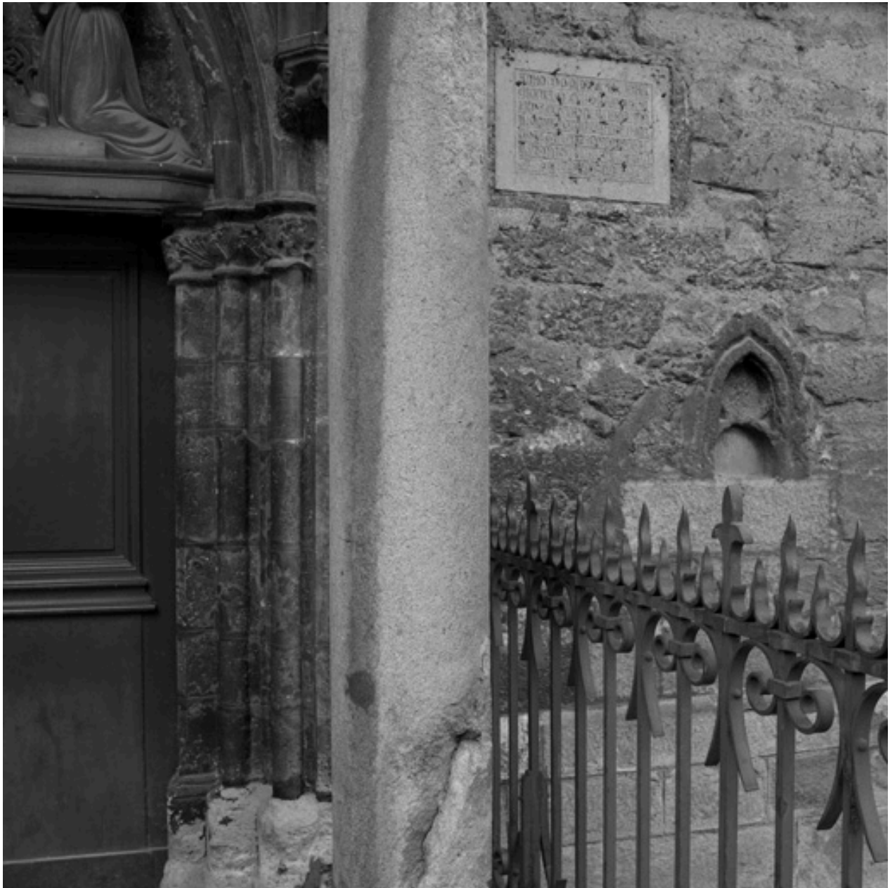
Elévation nord, travée VI : détail du portail et de la niche située à proximité.
