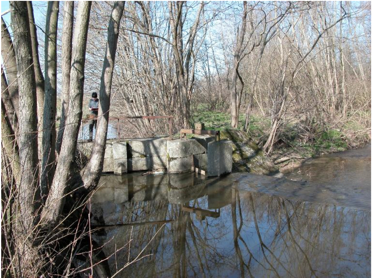
Vue d'ensemble amont de la prise d'eau en pierre de taille.
