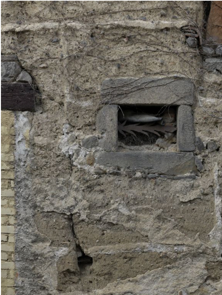
1986 AE 230. entre 24 et 26 rue Georges Guynemer. Cuvage, détail des matériaux mis en oeuvre.
