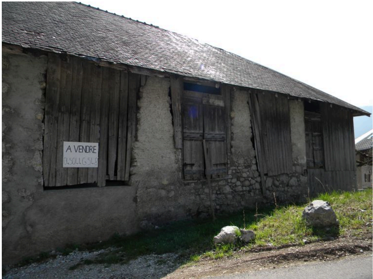
Vue de la façade arrière.
