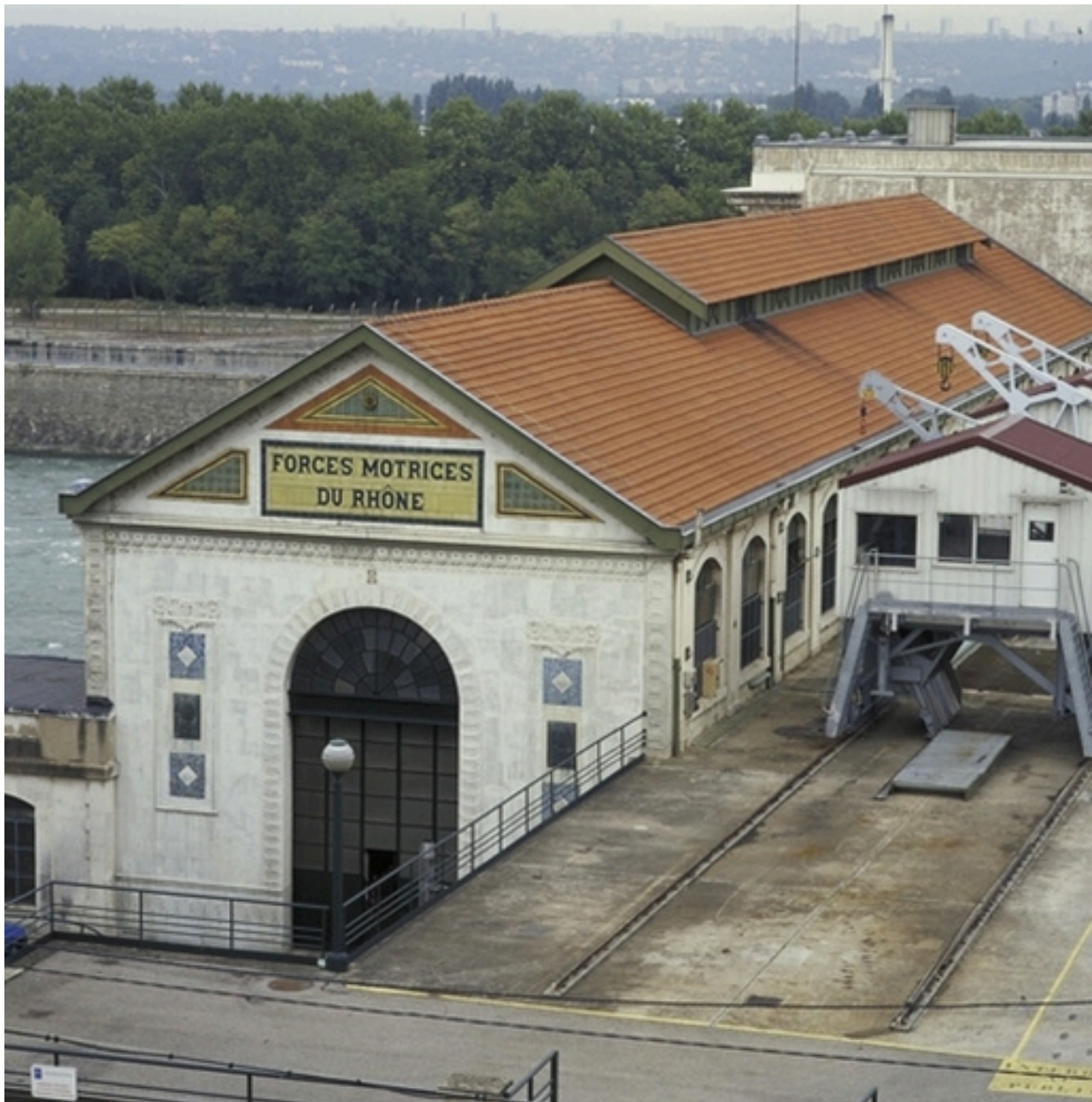
Vue sud : détail toit aérateur
