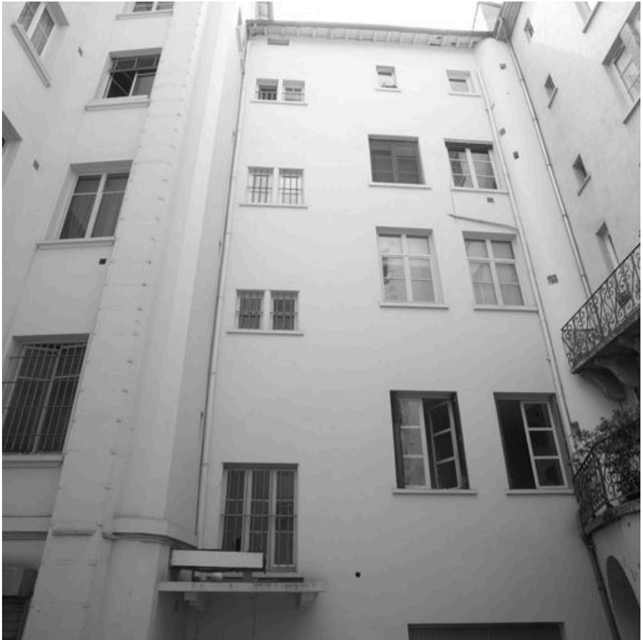
Corps arrière, partie subsistante de l'élévation sur l'ancienne cour d'entrée du prieuré de la Platière, vue générale par-dessous
