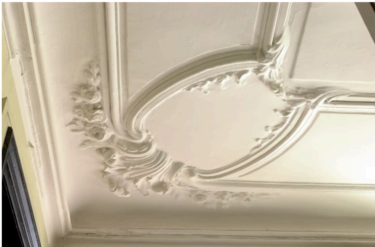
Plafond de la cage de l'escalier principal, détail de l'angle sud-est
