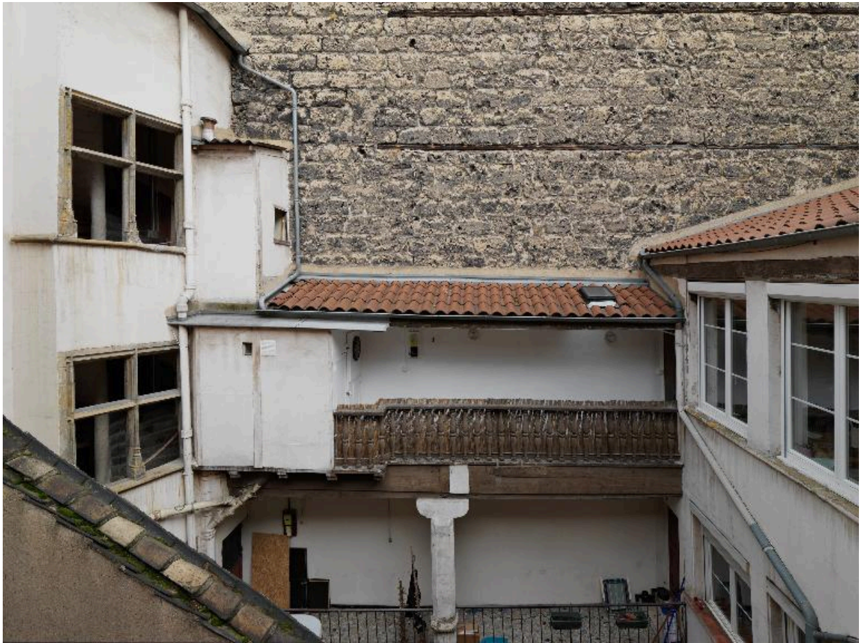
Galerie desservant le corps de bâtiment sur cour au quatrième étage
