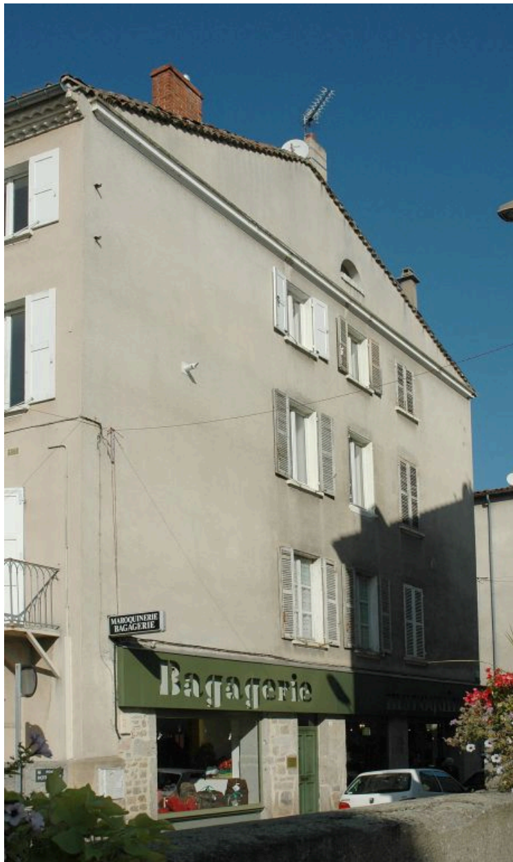
Vue de l'élévation sur la rue Notre-Dame.
