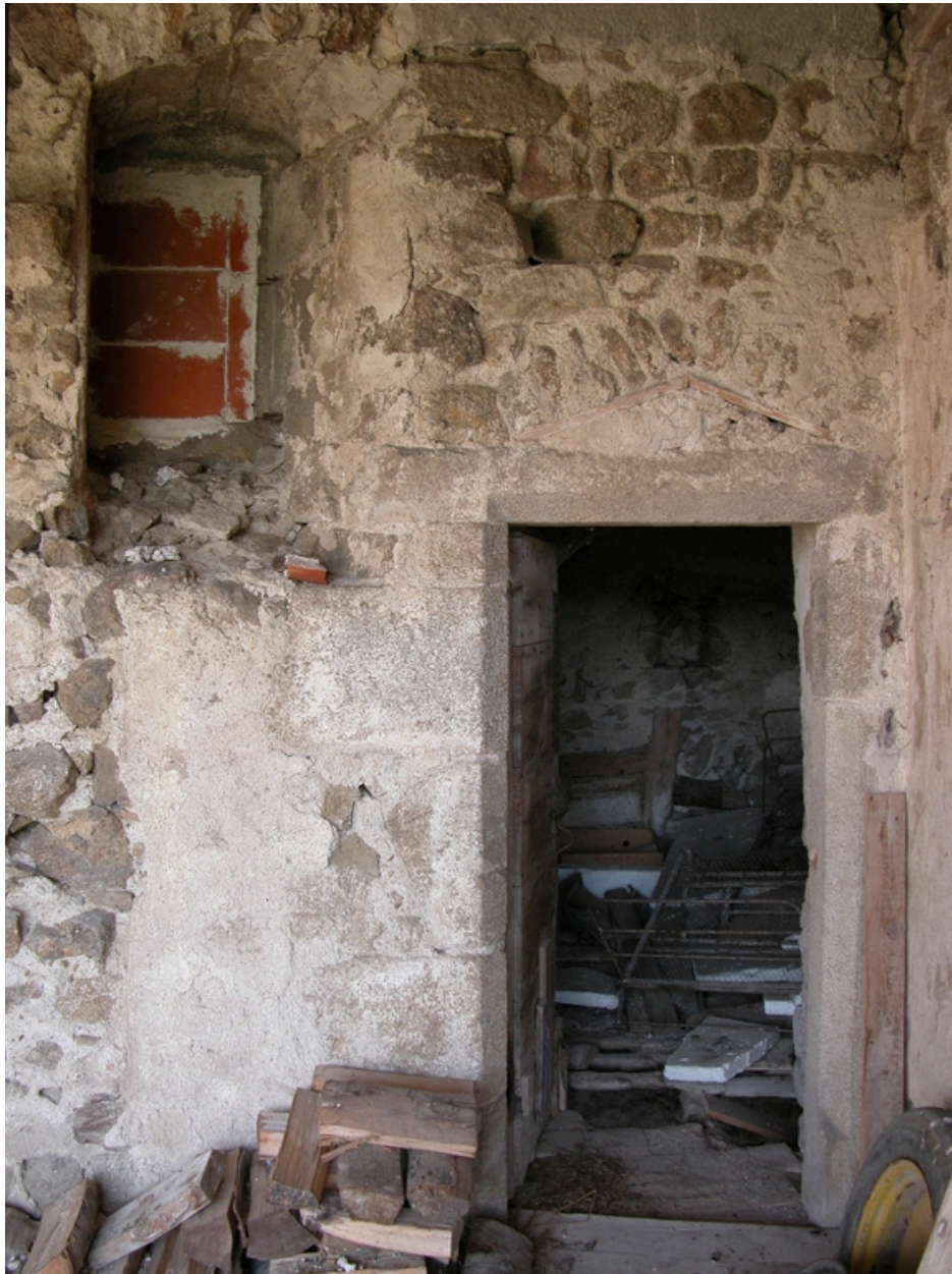
Porte et baie haute de la cave voûtée située à l'est de l'ancienne cuisine au niveau de l'étage de soubassement
