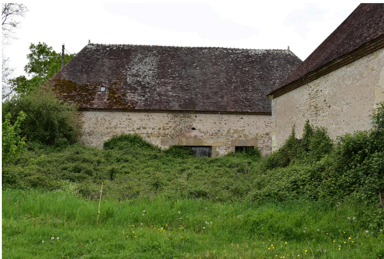
Grange sud-ouest du château de Beauregard
