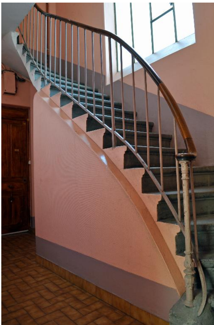
Immeuble sur cour, le départ de l'escalier droit à volée courbe
