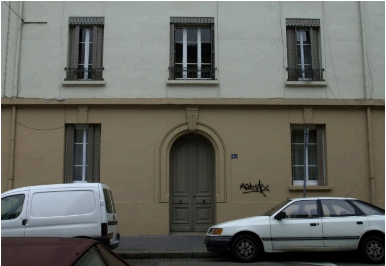
43 rue Smith, la porte d'entrée
