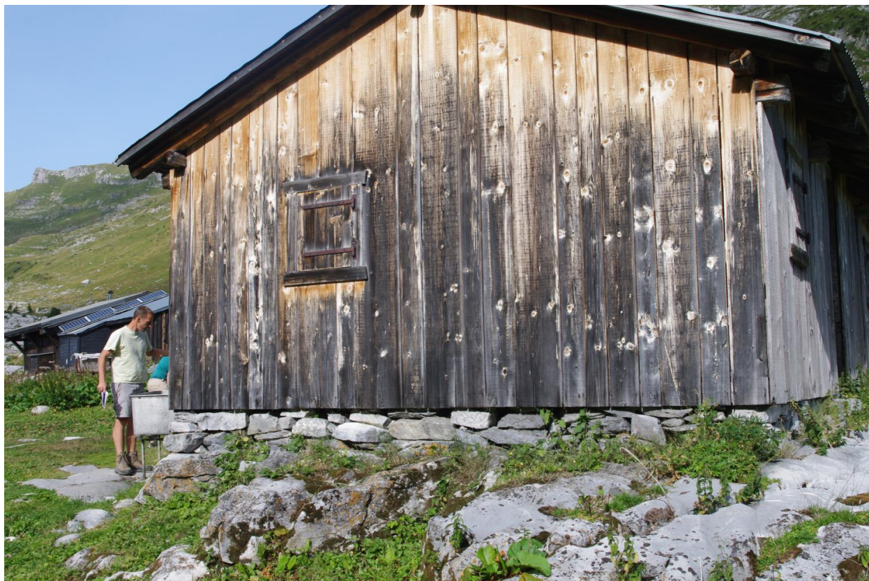
Vue du mur pignon ouest
