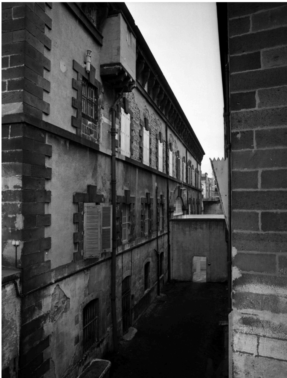
Depuis le chemin de ronde nord, élévation arrière (ouest) du bâtiment G (de l'administration).
