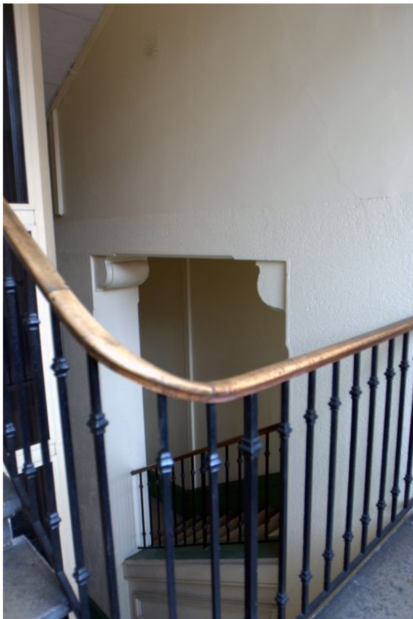
1ère volée de l'escalier, depuis le 1er repos
