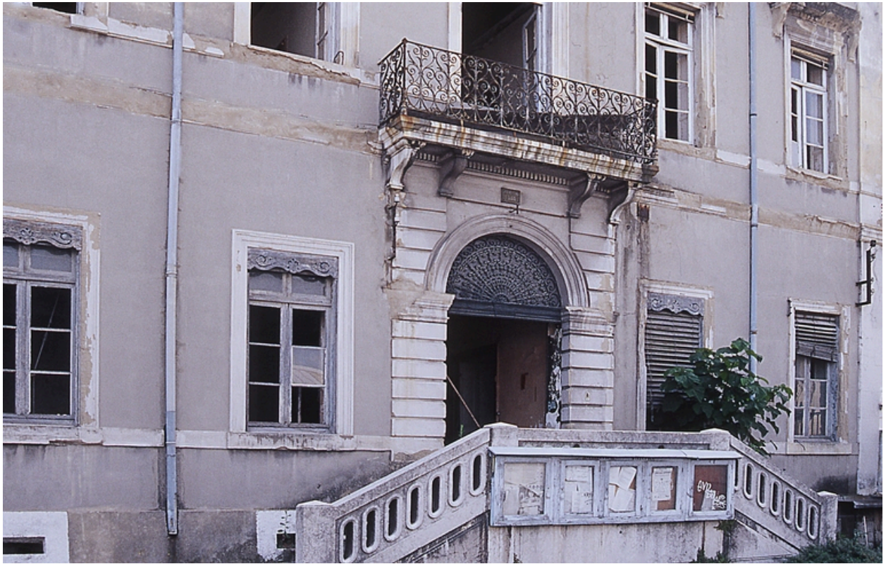
Pavillon sud entrée
