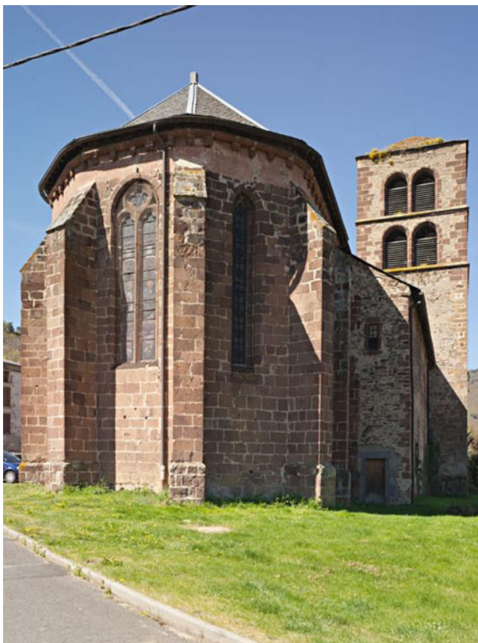
Vue générale du chevet.
