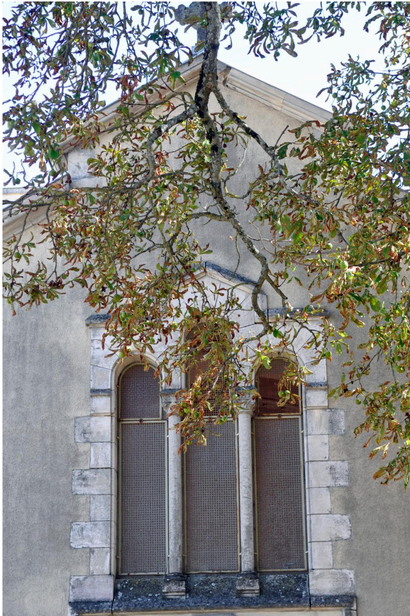
Elévation ouest, percée d'une grande baie triple
