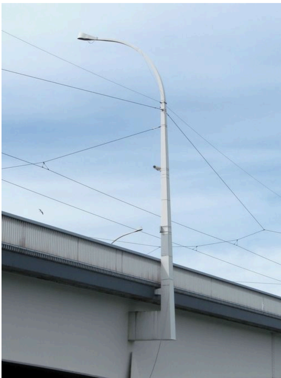
Tablier, face amont, vue de détail : lampadaire (depuis la rive gauche)
