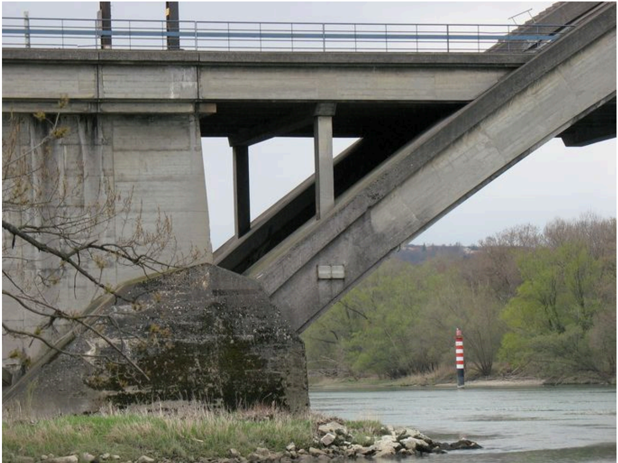
Vue de la retombée de l'arc en rive gauche, face amont (depuis la rive gauche)
