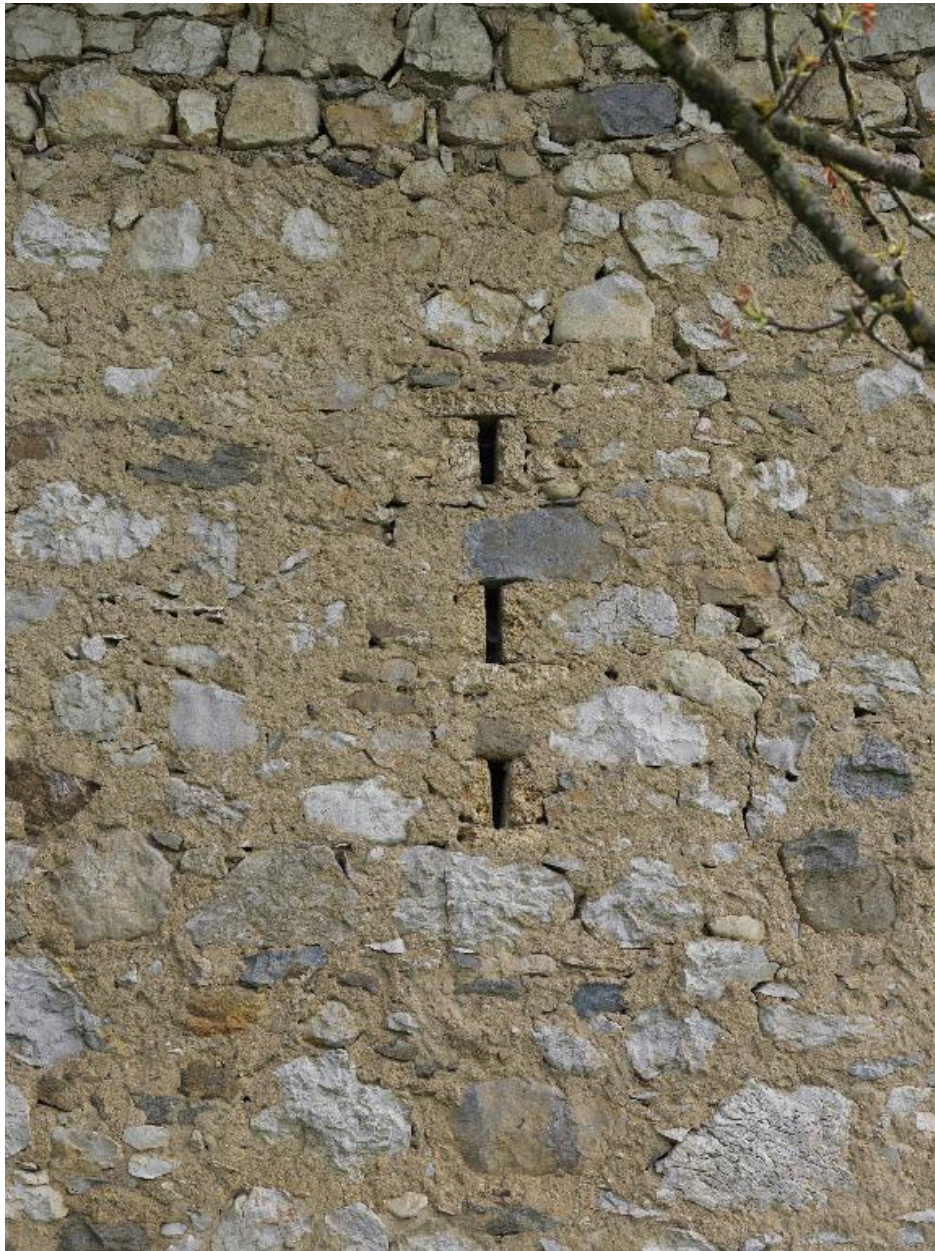
Détail des ouvertures extérieures du placard mural "fridaire".
