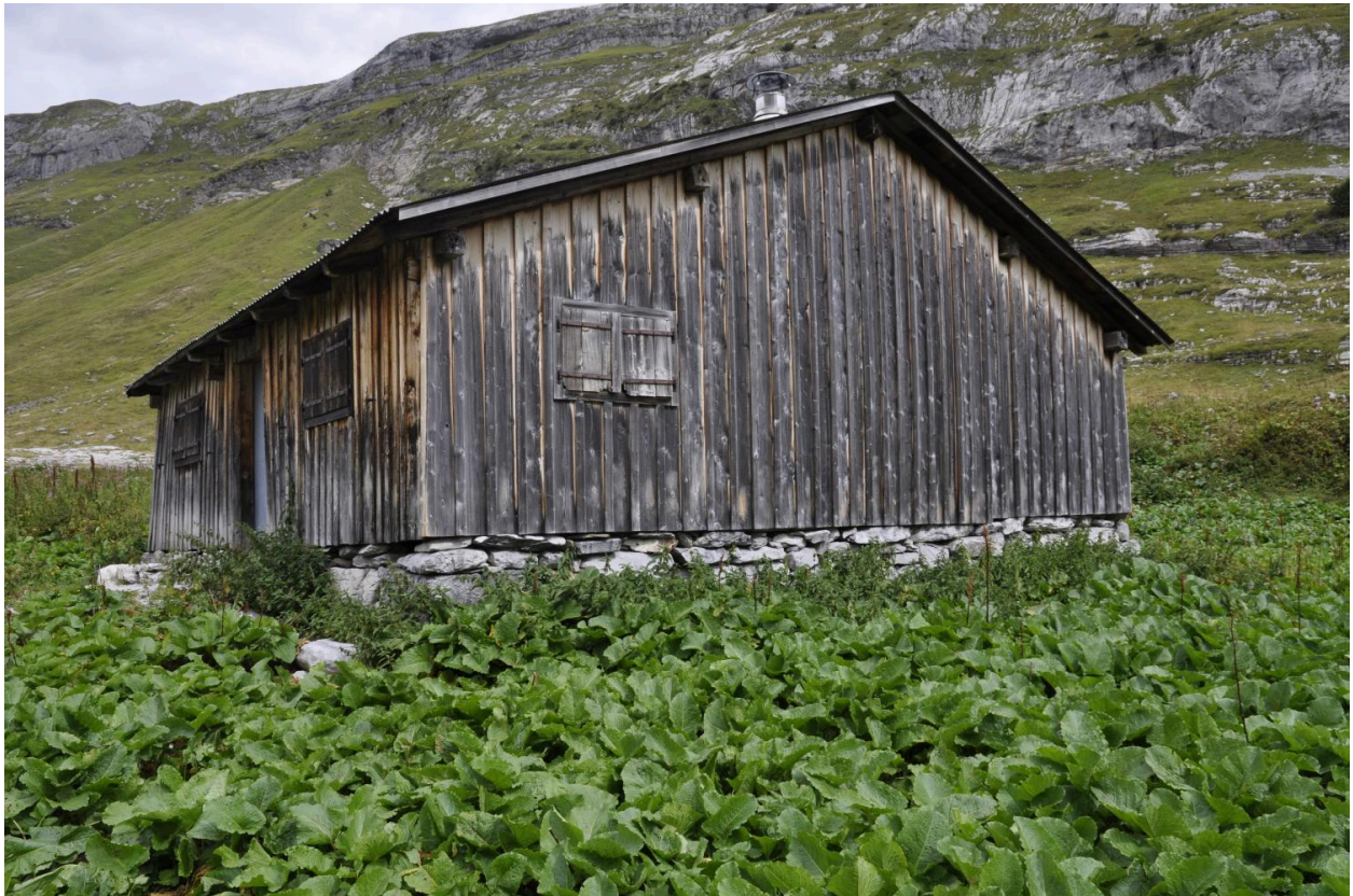
Vue de l'élévation sud-est du bâtiment
