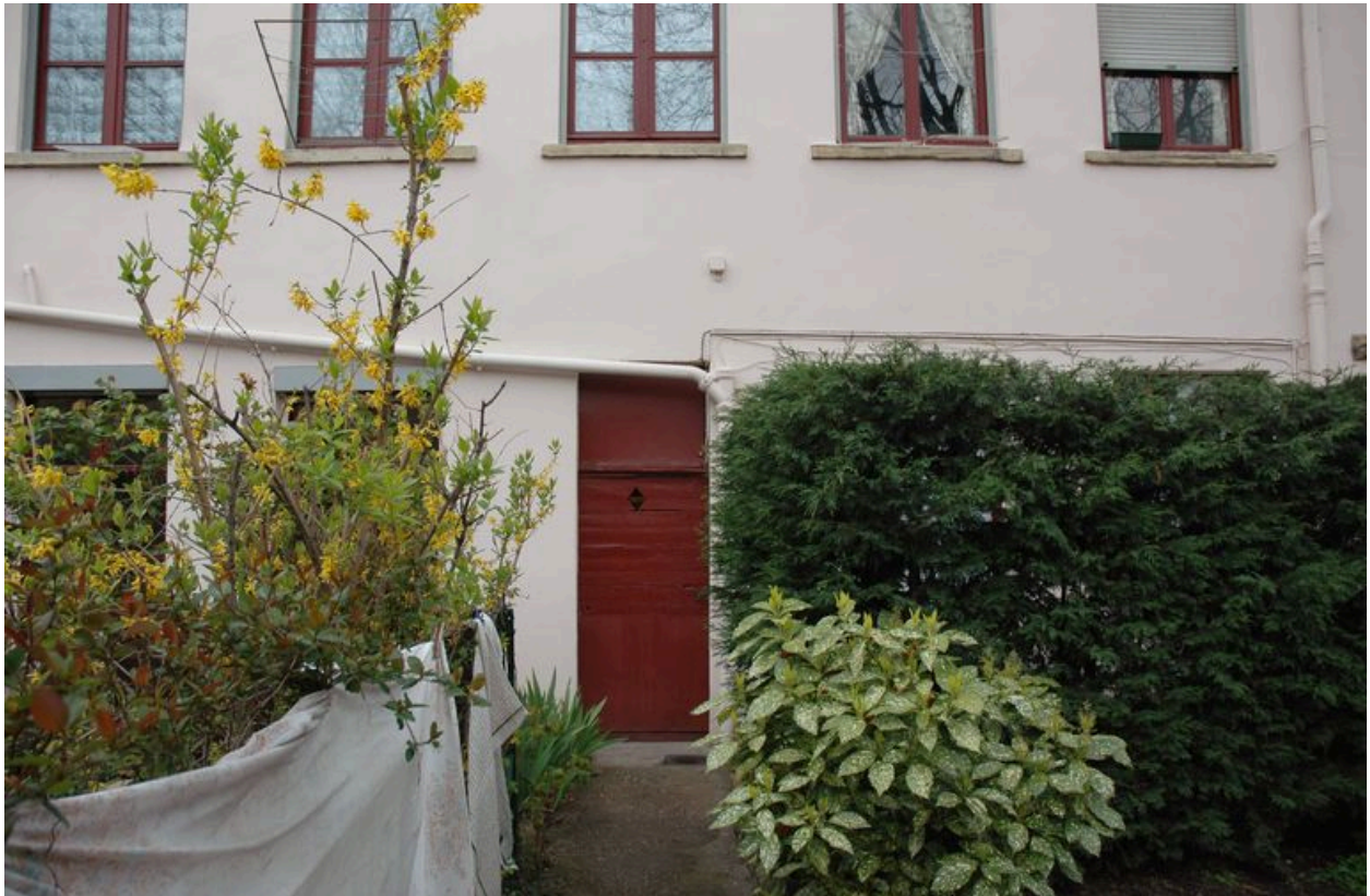
Entrée donnant accès à l'allée sur le façade est, vue depuis le jardin
