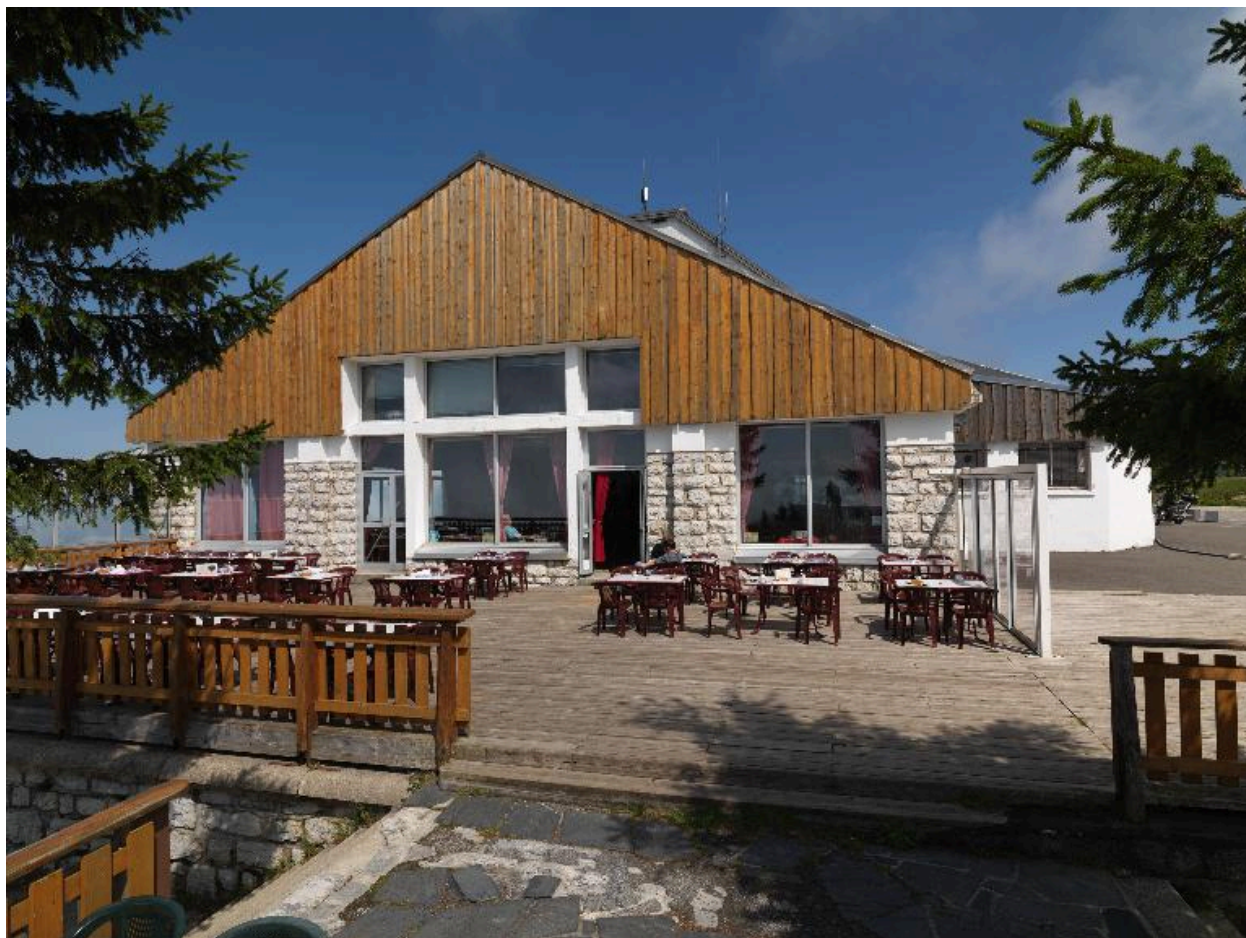
Pignon sud et terrasse du restaurant
