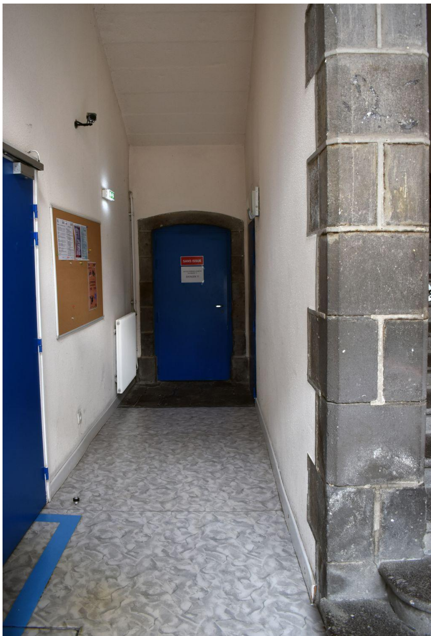
Bâtiment B : porte donnant accès aux caves nord, au pied de l'escalier C
