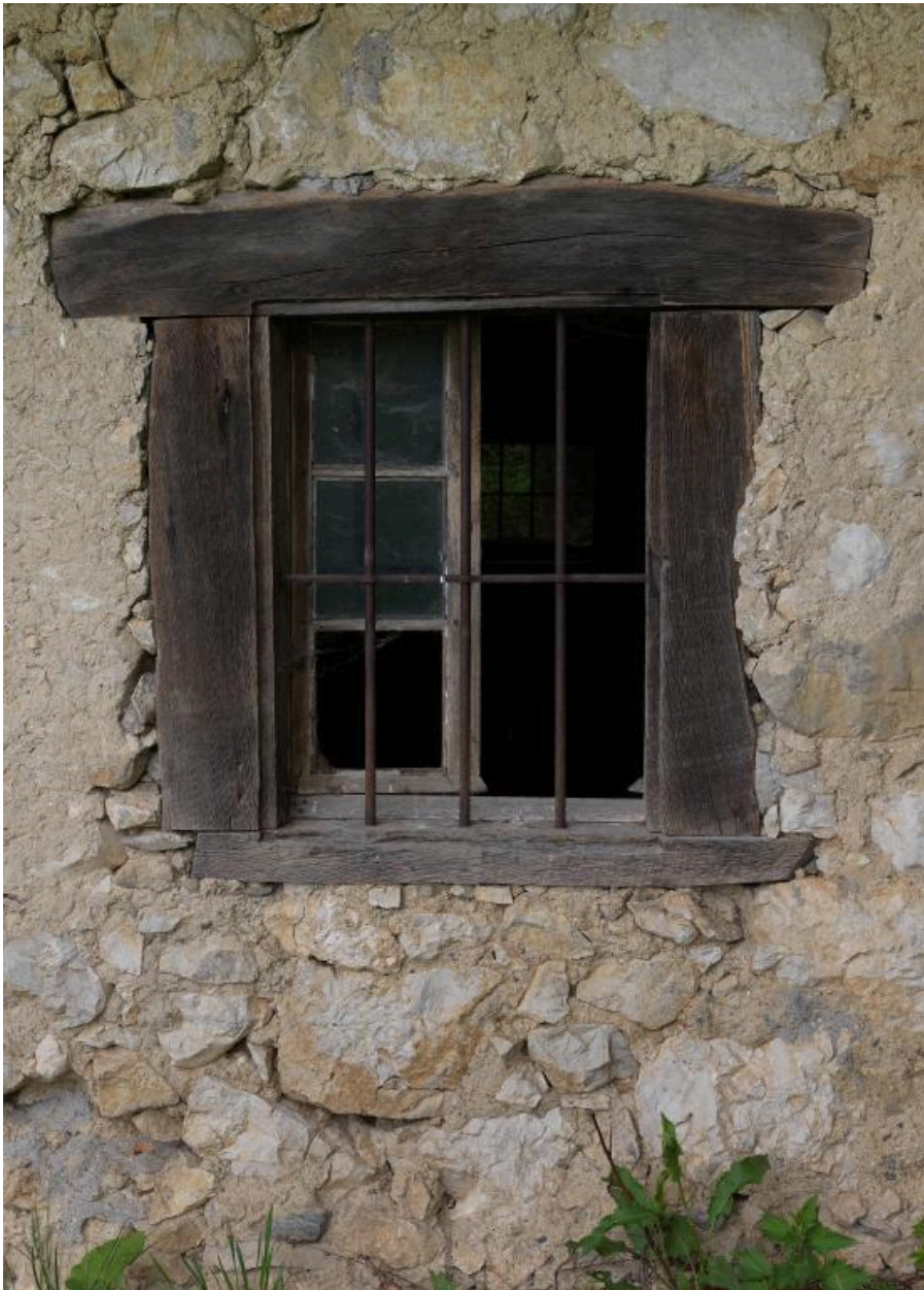
Vue d'ensemble de la baie de la chambre donnant sur le mur gouttereau sud-ouest.
