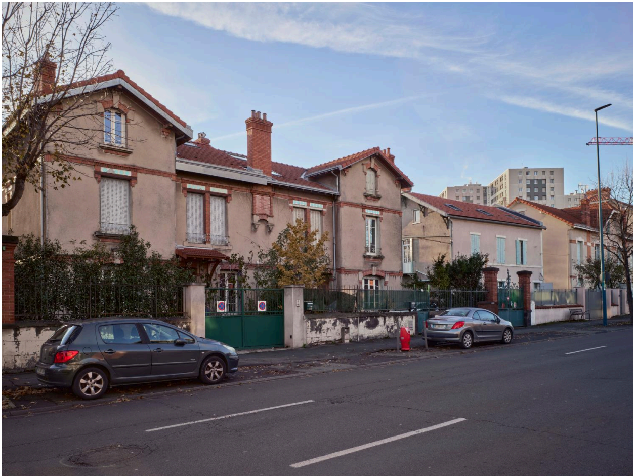
Elévation principale des n°129 et 131 boulevard Lavoisier
