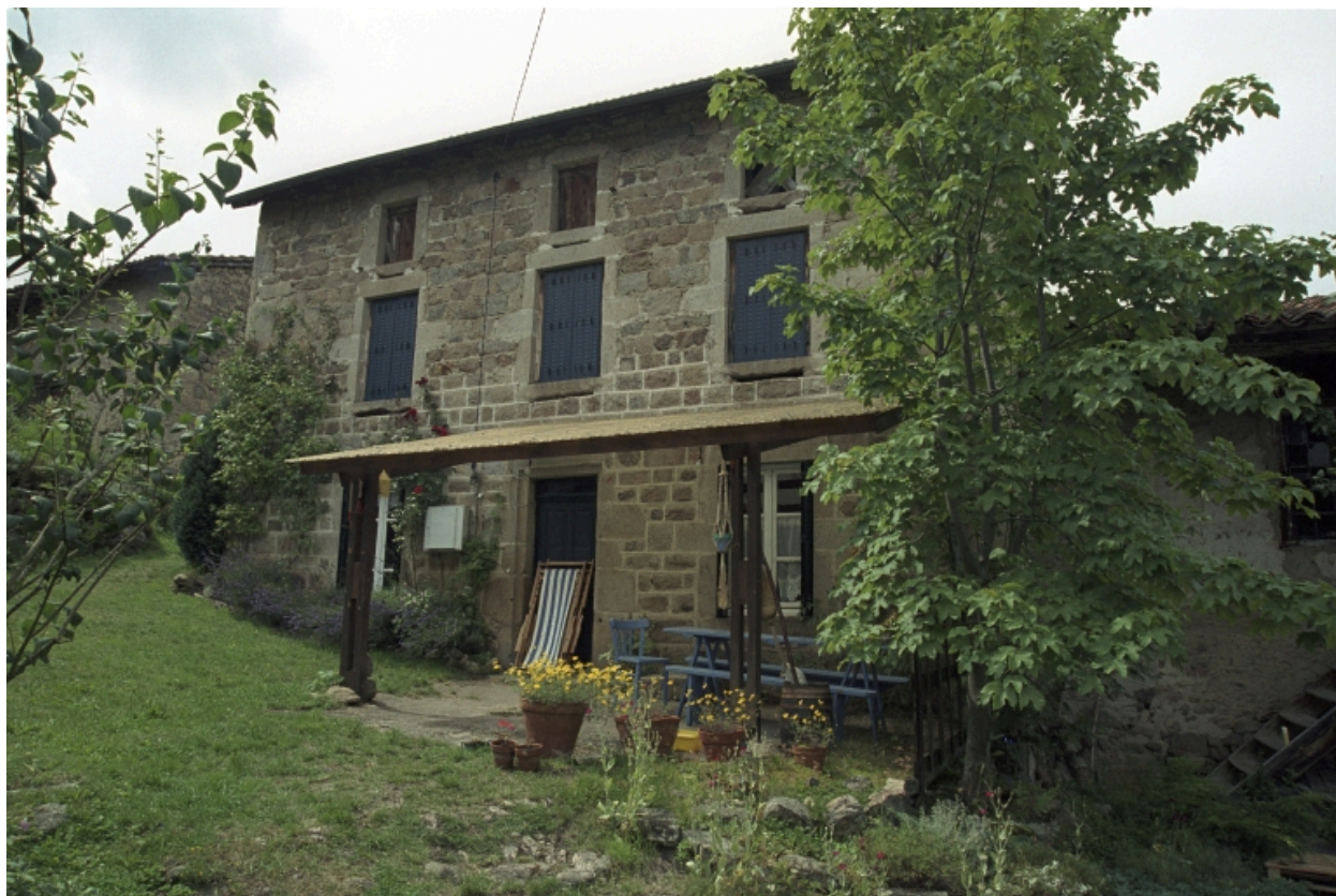
Saint-Laurent-Rochefort, Chazelles Bas (1987 C3 763), type A1. Vue d'ensemble de la ferme.
