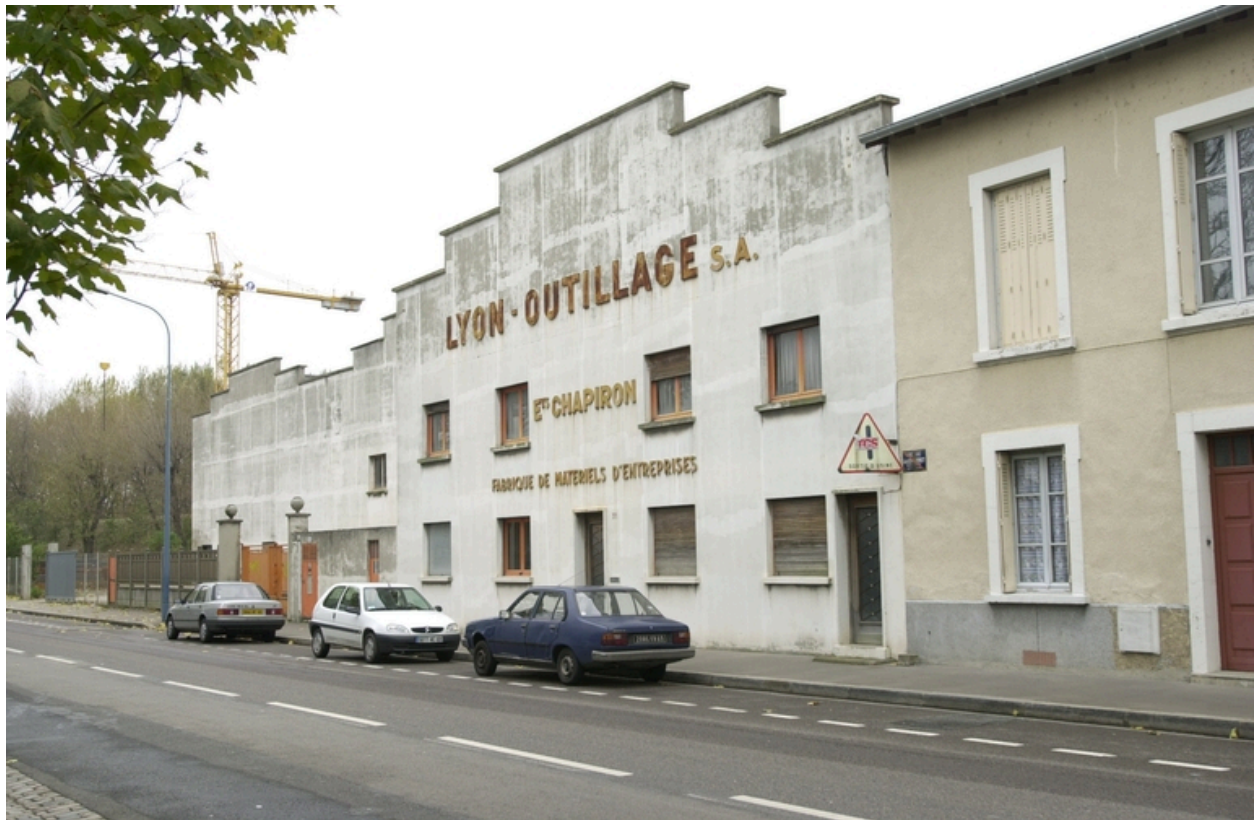
Vue générale est
