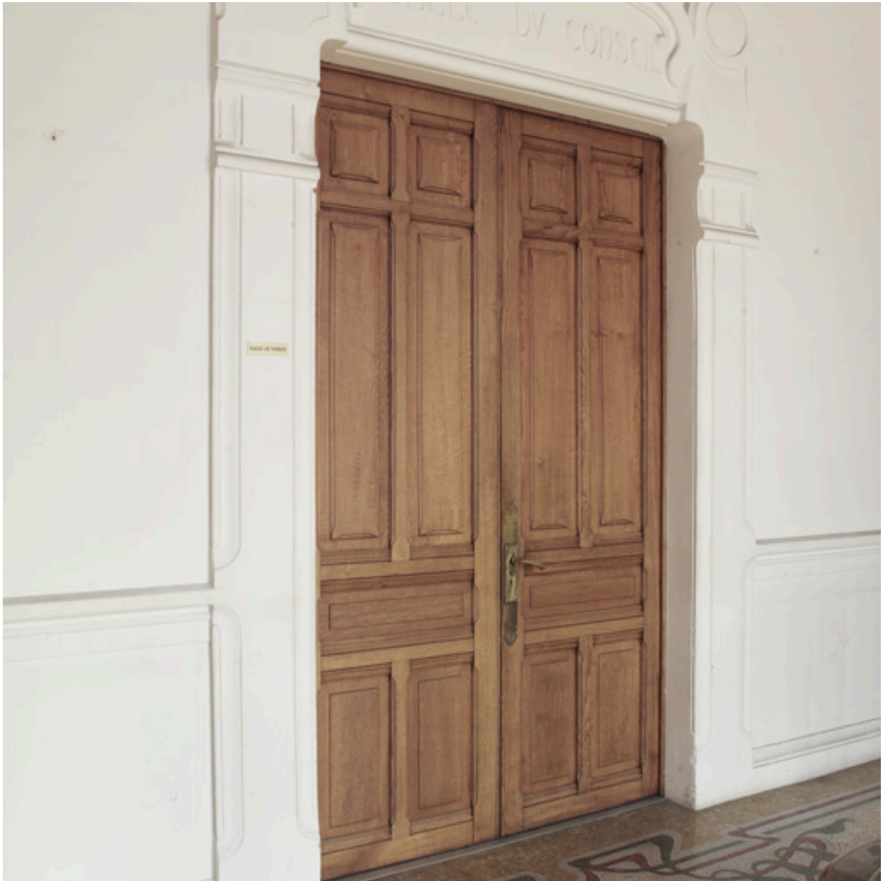
Menuiserie de la porte d'entrée de la salle du conseil.
