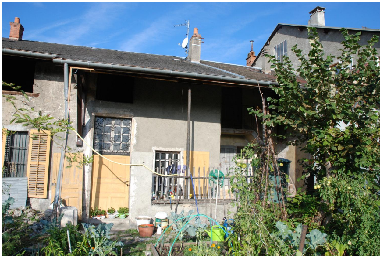
Maison 37 rue Jean-Louis Bouvet (2018 E1 362, 363). Vue de l'élévation sur cour.
