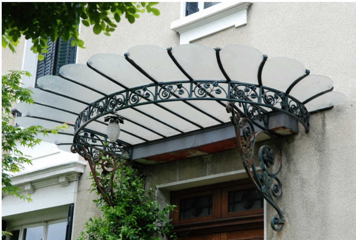
Détail auvent entrée de la maison
